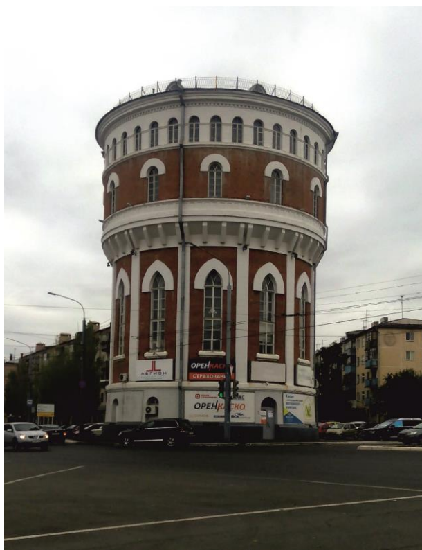
Рис. 5. Водонапорная башня. Оренбург, пр. Победы, 14/1. Арх. И.В. Рянгин
