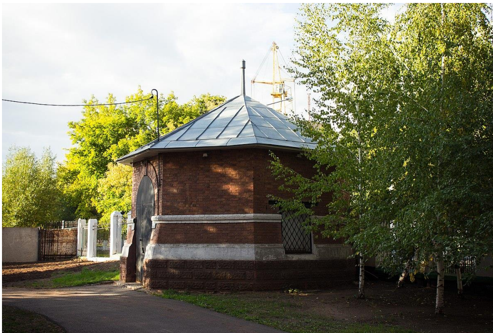
Рис. 4. Будка водоразборная, г. Оренбург, ул. М. Жукова, 5
