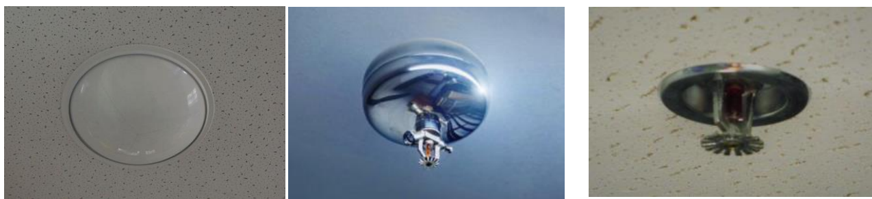
Рисунок 2. Оросители с зеркальным отражателем или с устройством углубленного монтажа
