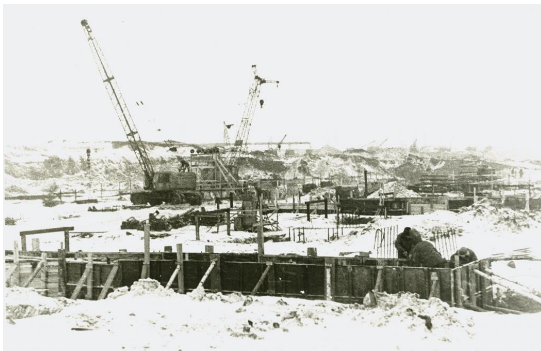
Рисунок 1 — строительство комбината в 1940-х годах
