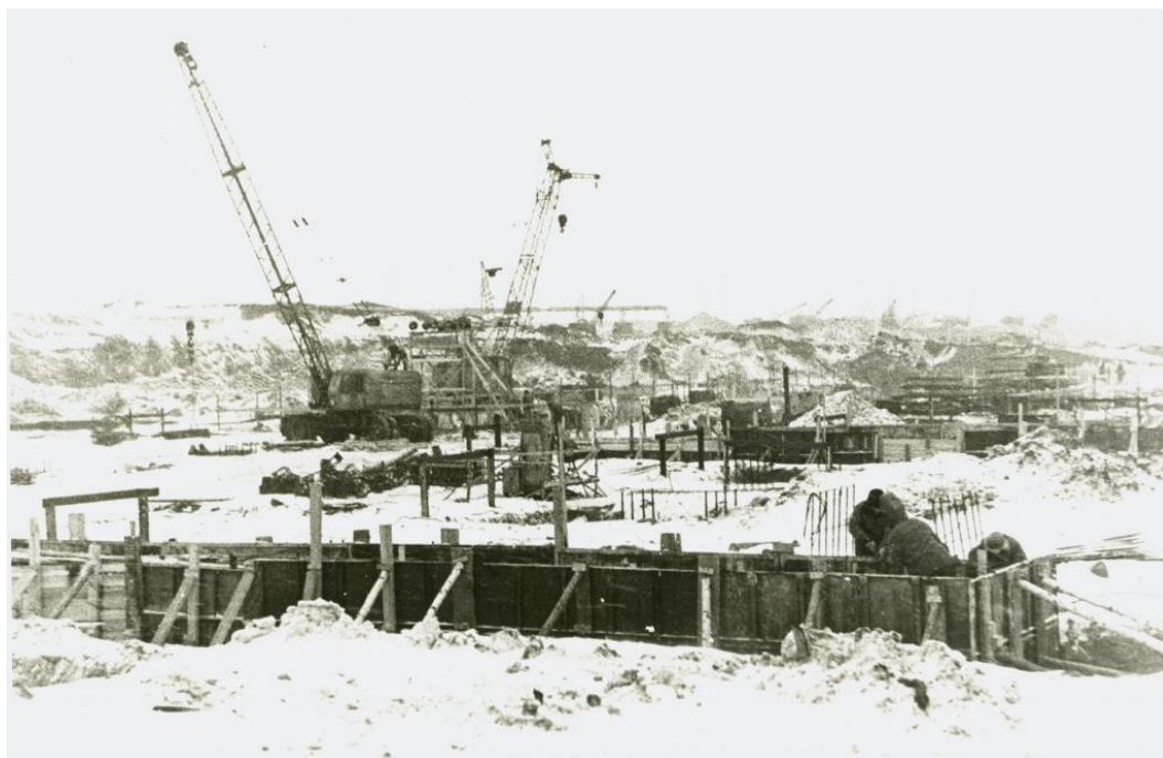
Рисунок 1 — строительство комбината в 1940-х годах
